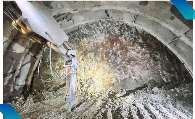
Εικόνα 36. Εργασίες εκσκαφής στο μέτωπο της σήραγγας (Εκδρομή «Παύλος Μαρίνος», 12/2025)
