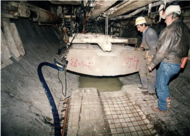
Εικόνα 69. Τοποθέτηση προκατασκευασμένων στοιχείων δαπέδου από οπλισμένο σκυρόδεμα (κάτω από το TBM) στο δάπεδο της σήραγγας προσαγωγής.
