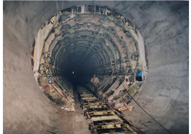
Εικόνα 72. Σιδηρότυπος σκυροδέτησης της τελικής επένδυσης της σήραγγας προσαγωγής Μεσοχώρας.
