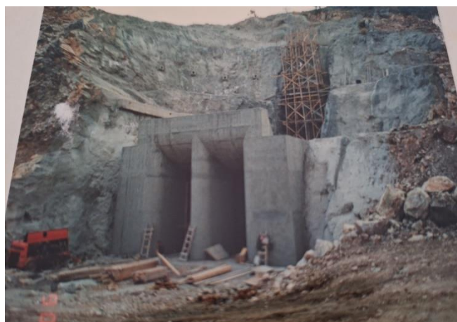
Εικόνα 52. Άρτι σκυροδετημένο τεχνικό εισόδου σήραγγας εκτροπής φράγματος Μουζακίου στον ποταμό Πάμισο.
