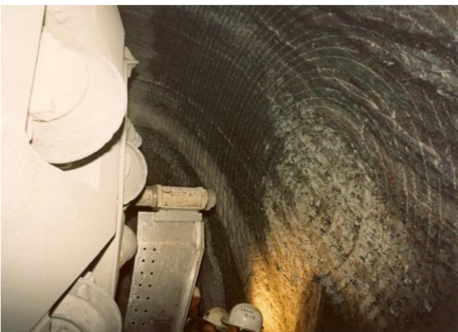
Εικόνα 71. Εικόνα πολύ καλής ποιότητας βραχομάζα (Κατηγορίας Ι) μπροστά από την κοπτική κεφαλή του TBM στη σήραγγα προσαγωγής Μεσοχώρας.
