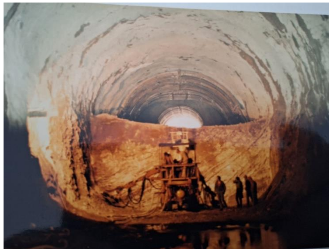
Εικόνα 50. Υπόγεια εκσκαφή κάτω Β' φάσης (bench) στην σήραγγα εκτροπής Νο. 1 του φράγματος Συκιάς (στο δεξιό αντέρρισμα του Αχελώου).
