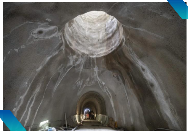
Εικόνα 32. Σήραγγα προσαγωγής και σύνδεση με κατακόρυφο φρέαρ πίεσης του έργου αντλησιοταμίευσης Αμφιλοχίας (Εκδρομή «Παύλος Μαρίνος», 12/2025)
