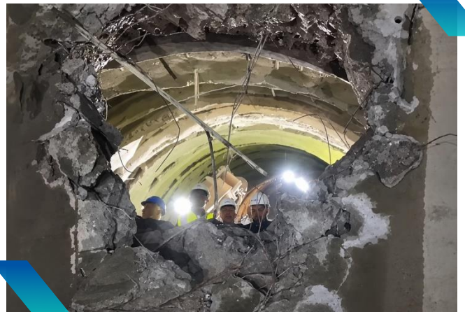
Εικόνα 31. Breakthrough της Α' φάσης διάνοιξης της δίδυμης σήραγγας Σ2 στην περιοχή Σεληναρίου, Αύγουστος 2026 (Πηγή: ΑΚΤΩΡ social media)
