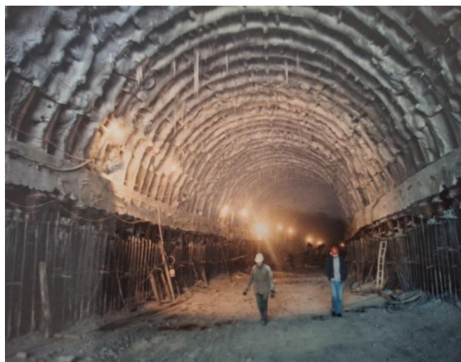
Εικόνα 51. Υπόγεια εκσκαφή της οδικής σήραγγας Πλακαριών στην Οδό Τρικάλων – Μεσοχώρας (στην διάρκεια χειμερινών μηνών-αποστράγγιση σε στερεά μορφή).
