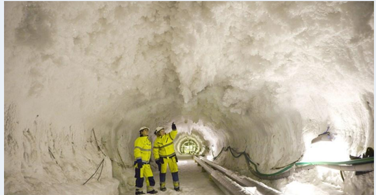
Εικόνα 117. Εσωτερικό της τεχνητά παγωμένης ζώνης κατά την εφαρμογή της μεθόδου AGF στη σήραγγα Hallandsås, Σουηδία. ( https://www.skanska.com/se/en/construction-infrastructure/our-projects/hallandsas )
