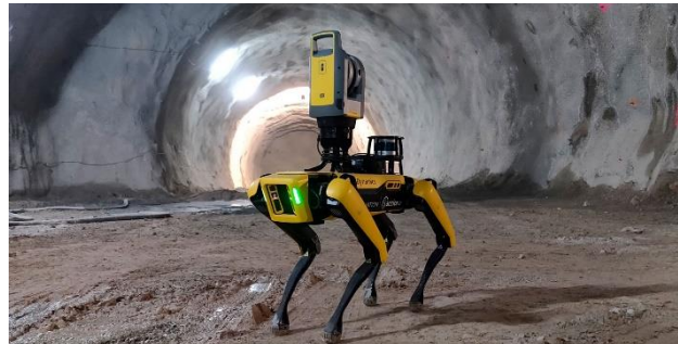
Εικόνα 84. Τετράποδη ρομποτική πλατφόρμα εξοπλισμένη με σαρωτή 3D LiDAR σε υπόγειο μεταλλευτικό έργο στο Chuquicamata της Χιλή. Η εφαρμογή περιλαμβάνει 3D αποτύπωση, έλεγχο διατομών και εκτοξευόμενου σκυροδέματος και χαρτογράφηση μετώπου εκσκαφής (ACCIONA)
