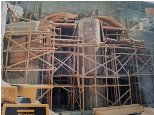
Εικόνα 53. Σκυροδέτηση τεχνικού εισόδου σήραγγας εκτροπής φράγματος Πύλης στον ποταμό Πορταϊκό.
