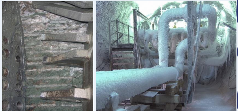
Εικόνα 118. Μέτωπο εκσκαφής στη ζώνη ρήγματος Mölleback μετά την εφαρμογή της μεθόδου (AGF). Διακρίνεται πλήρως αποσαθρωμένος γνεύσιος και τεμάχια υγιούς πετρώματος εντός της παγωμένης βραχώμαζας (Sturk, R et al, 2011)
