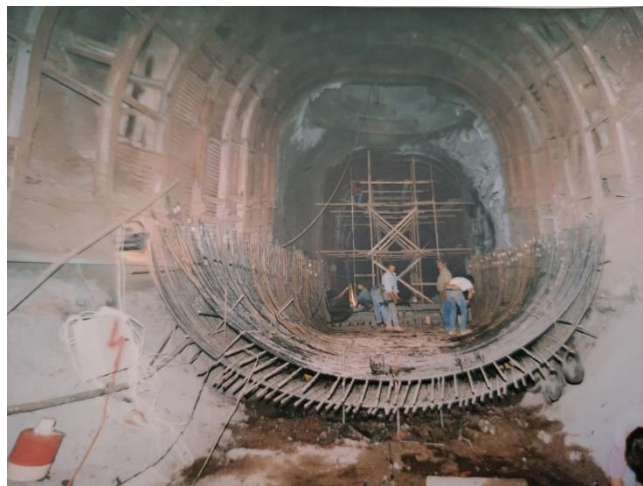
Εικόνα 58. Τοποθέτηση σιδηροπλισμού για σκυροδέτηση δαπέδου μεταβατικής ζώνης της σήραγγας προσαγωγής προς την υδροληψία του φράγματος Μεσοχώρας.
