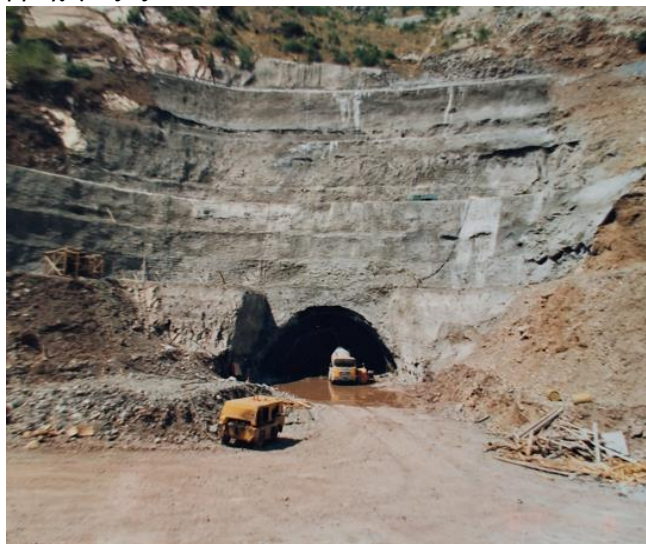
Εικόνα 49. Μέτωπο εισόδου της σήραγγας εκτροπής Μεσοχώρας στην πρώτη άνω φάση εκσκαφής (κλείδας τη σήραγγας – top heading) και τον βασικό δρόμο προσπέλασης προς το έργο να βρίσκεται σε μια (ανώτερη) παγκίνα των ανοικτών εκσκαφών.
