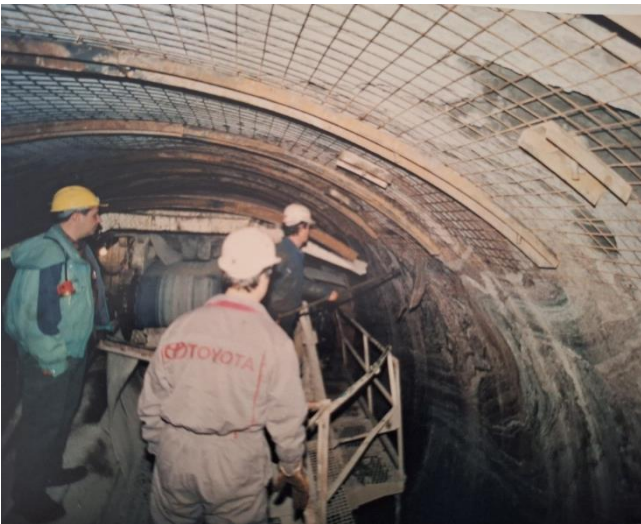
Εικόνα 70. Χώρος εργασίας για την τοποθέτηση των μέτρων άμεσης υποστήριξης πίσω από το TBM στη σήραγγα προσαγωγής Μεσοχώρας.
