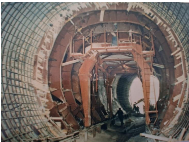
Εικόνα 54. Σκυροδέτηση τελικής επένδυσης σήραγγας εκτροπής φράγματος Πύλης στον ποταμό Πορταϊκό.
