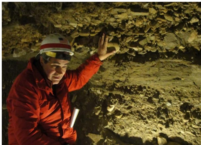
Εικόνα 105. Ο Παύλος Γ. Μαρίνος σε σήραγγα διανοιγμένη σε βραχομάζα υπό συνθήκες permafrost (μόνιμου παγετού, με θερμοκρασία της βραχομάζας \leq 0^{\circ}\text{C} για τουλάχιστον δύο συνεχόμενα έτη), Αλάσκα.
