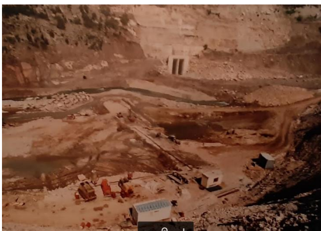
Εικόνα 55. Τεχνικό εισόδου της σήραγγας εκτροπής του φράγματος Μεσοχώρας στον ποταμό Αχελώο (στο βάθος) στην διάρκεια εργασιών στεγάνωσης του Προφράγματος με κουρτίνα τσιμεντενέσεων εδαφικού τύπου.
