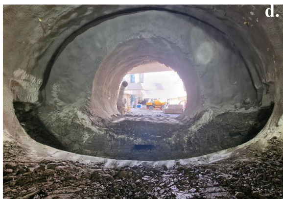
Εικόνα 44. Αλληλουχία εκσκαφής των OOC East Tunnels και ενδεικτικές φωτογραφίες σταδίων κατασκευής: Πάνω: Κατασκευαστική ακολουθία, Κάτω: α,β: Διάνοιξη πιλότου, γ: Πρώτη φάση διεύρυνσης στη σύνδεση, δ,ε: Ολική διεύρυνση και προετοιμασία αρμών. (προσαρμογή από Malhan et al., 2026)
