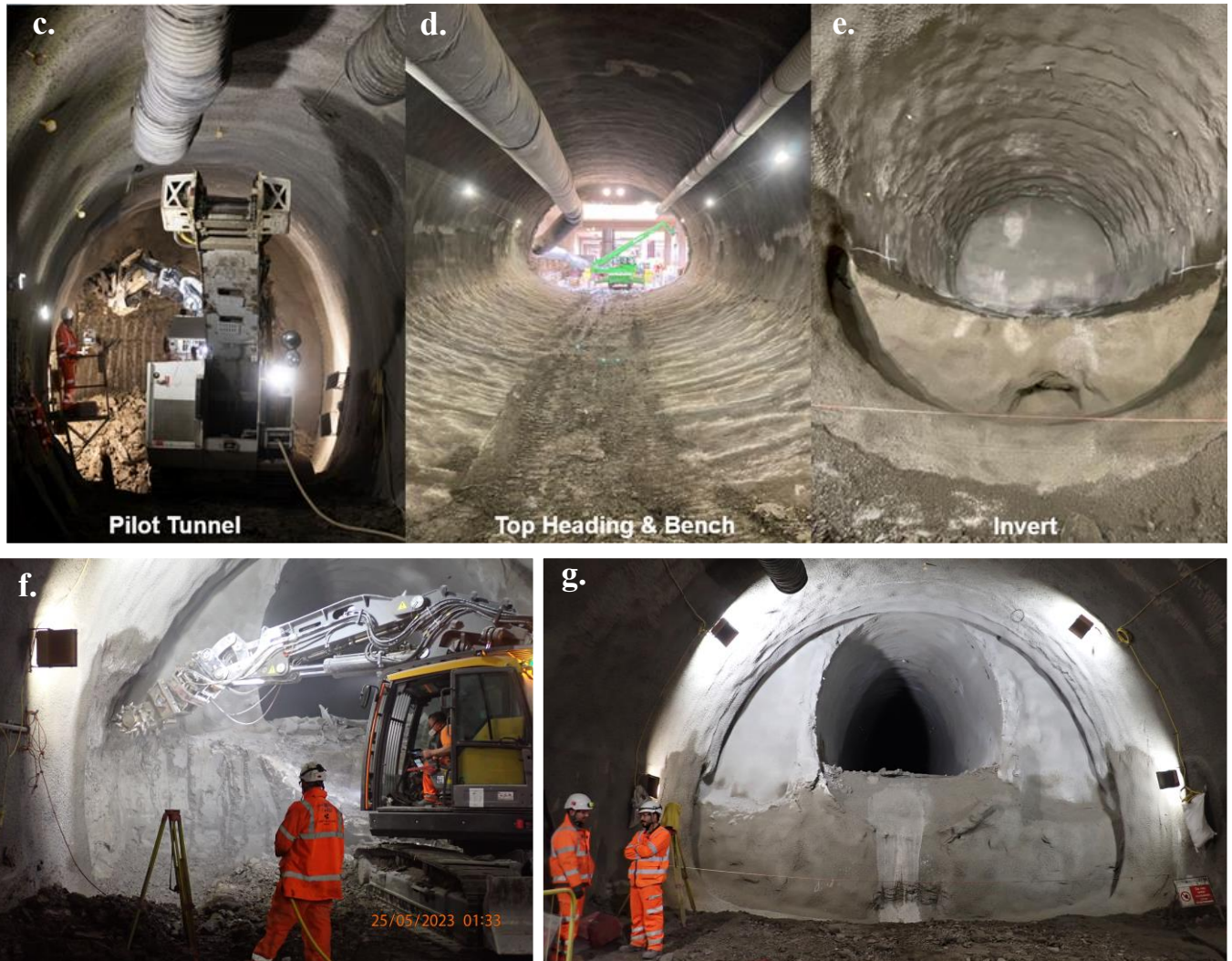
Εικόνα 43. Εργοταξιακή οργάνωση, στάδια εκσκαφής και ποιότητα αρμών/διεπιφανειών στις Ανατολικές Σήραγγες c. Εκσκαφή πιλότου, d. Άνω φάση και e. Κάτω φάση διεύρυνσης f. Προετοιμασία αρμού μεταξύ φάσεων και g. Εγκατάσταση ανάστροφου τόξου (προσαρμογή από Vazaios et al., 2025)
