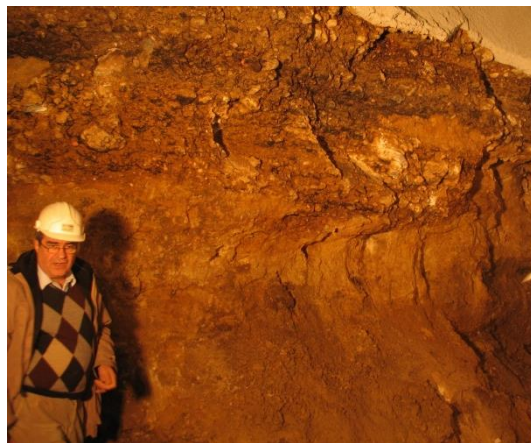
Εικόνα 89. Ο Παύλος Γ. Μαρίνος σε μέτωπο εκσκαφής σήραγγας του Μετρό της Αθήνας.
