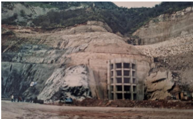
Εικόνα 59. Κατασκευασμένο (έργο πολιτικού μηχανικού-πύργος) το τεχνικό Υδροληψίας του φράγματος Μεσοχώρας.
