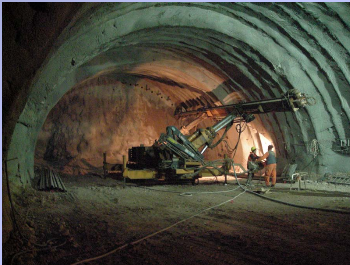
Κατασκευή δοκών προπορείας
