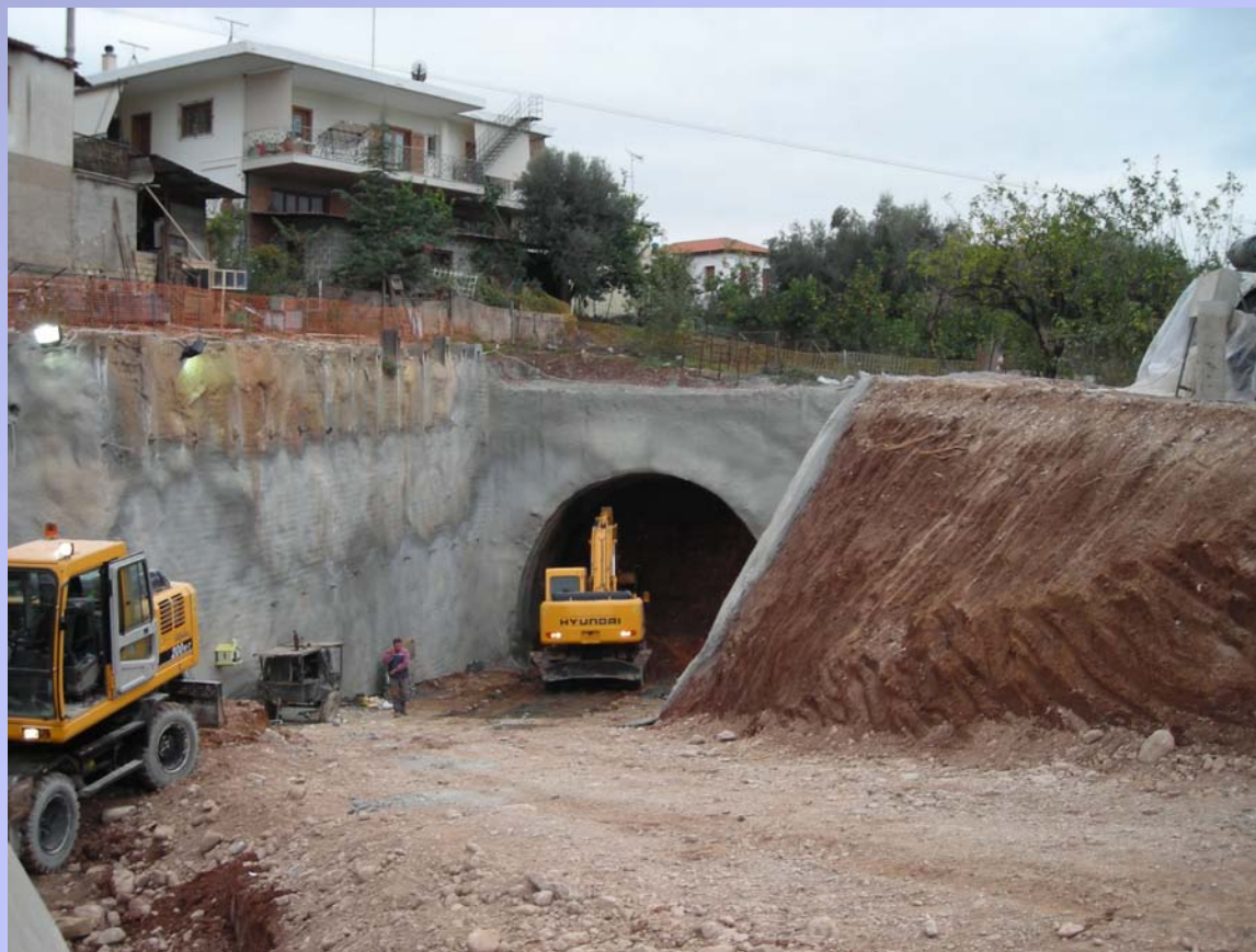
Στόμιο εισόδου της Σήραγγας Διαφυγής 1 (ΣΔ-1)
