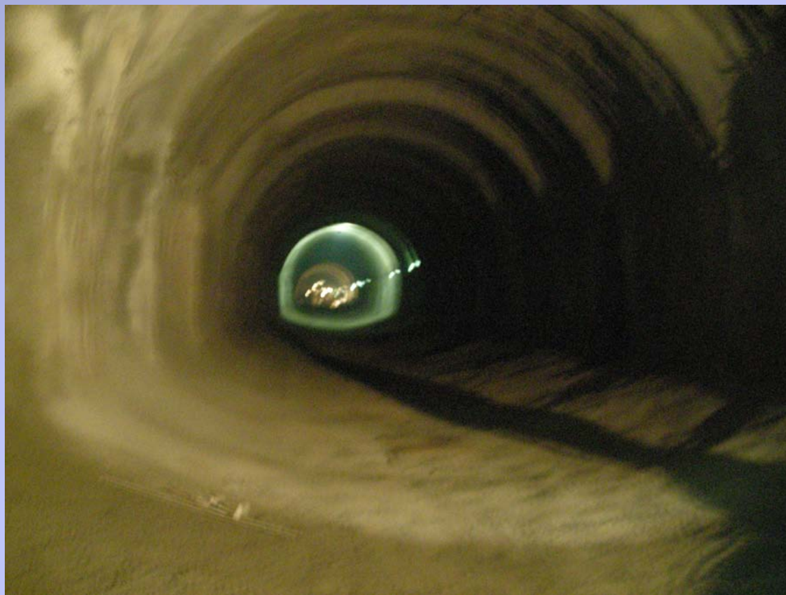
Κατασκευή invert προσωρινής επένδυσης Β' ΦΑΣΗΣ
