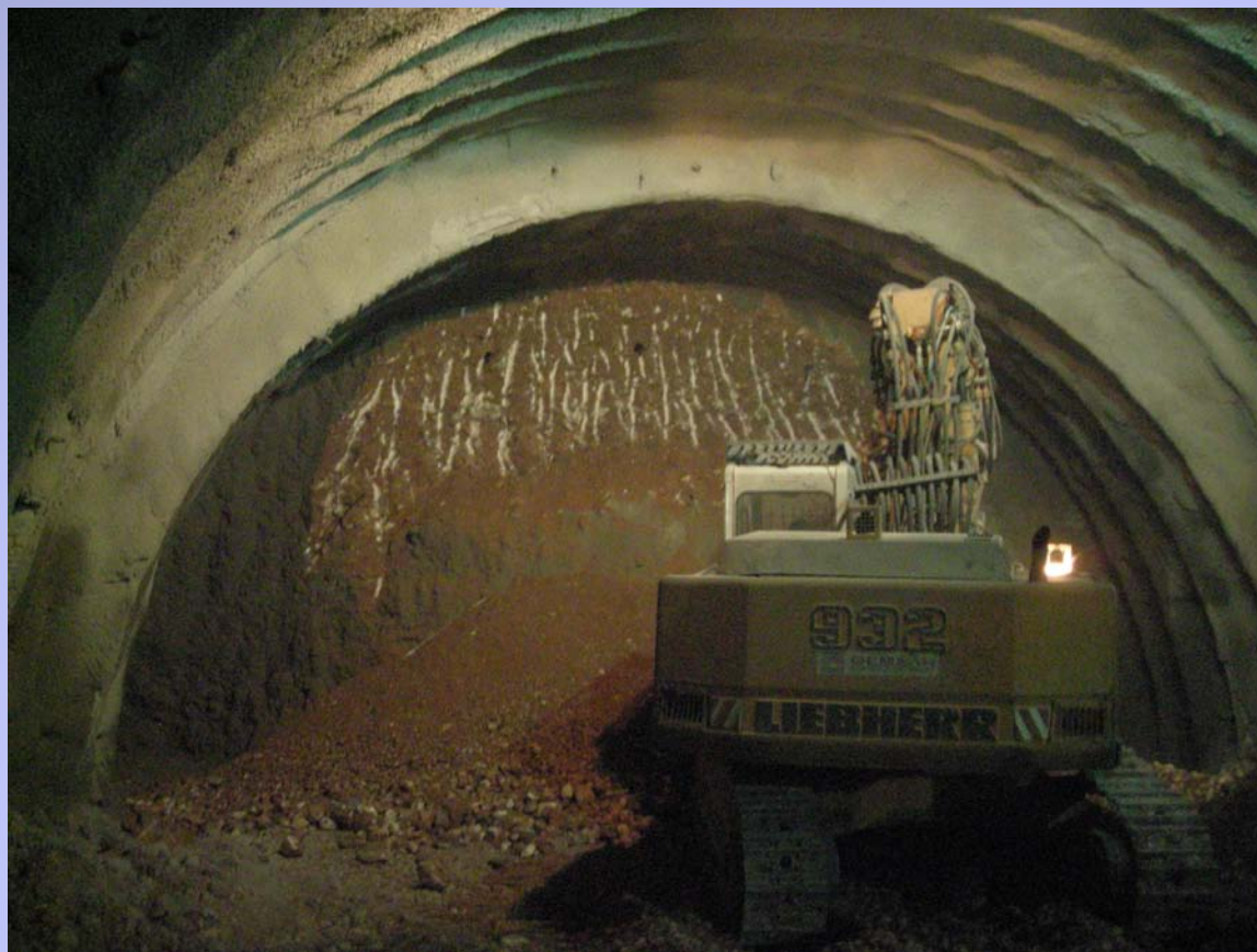
Εκσκαφή σήραγγας Α΄Φάση κατηγορία C
