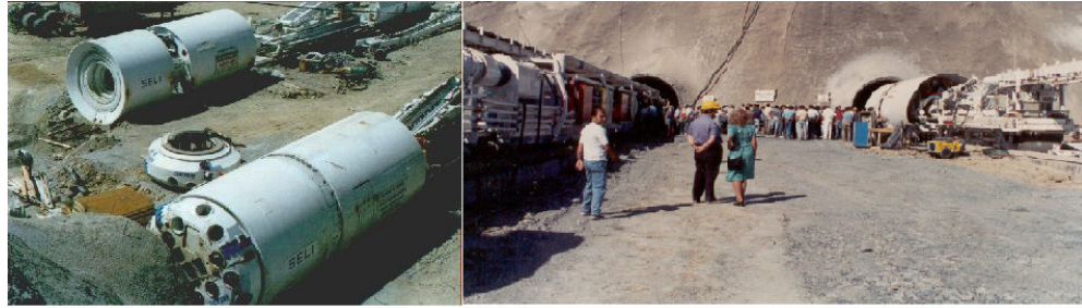
Εικόνα 4. Συναρμολόγηση των TBM στο σημείο C και η είσοδός τους στην σήραγγα.
