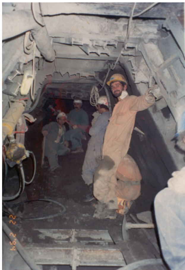
Εικόνα 16: Η στοά “by pass” πάνω από την ασπίδα του TBM.
