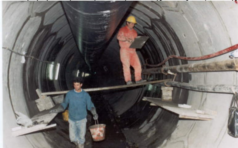
Εικόνα 10: Σφράγιση αρμών στην σήραγγα
