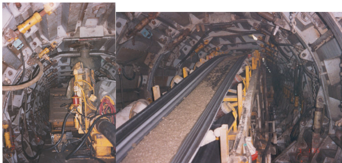
Εικόνα 6: Μεταλλότυπος και επανανάμιξη σκυροδέματος στο τμήμα D1E1
