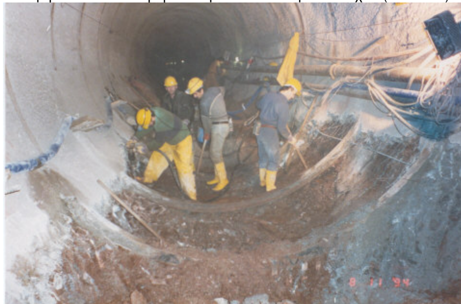
Εικόνα 14: Αποξήλωση του προκατασκευασμένου στοιχείου πυθμένα σε συνθλίβοντα σχηματισμό.
