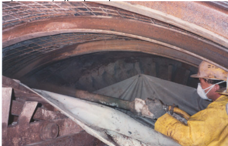
Εικόνα 12: Εφαρμογή εκτοξευομένου σκυροδέματος αμέσως πίσω από την κεφαλή
