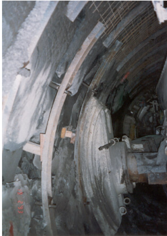
Εικόνα 3. Θραύση πετρώματος υπό την δράση του gripper
