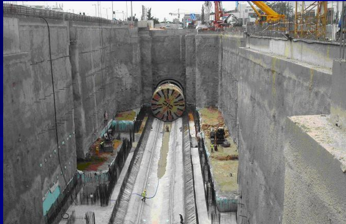
Ιούνιος 2007 το TBM στο όρυγμα του σταθμού Ελληνικό
