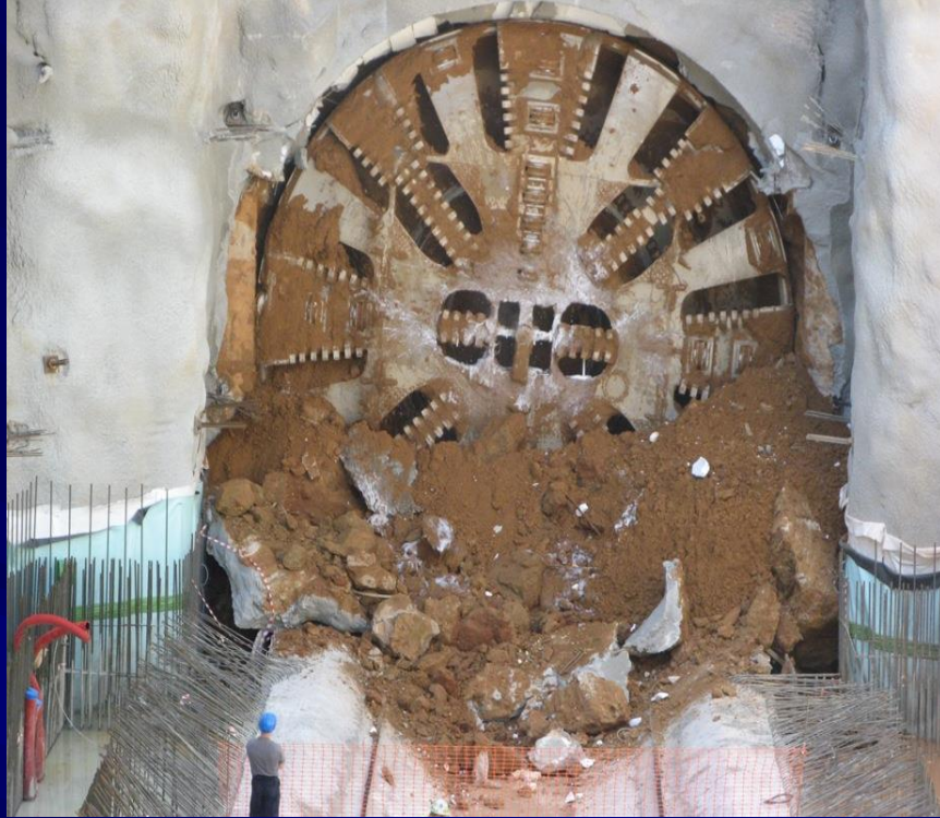
Ξετρύπημα στο όρυγμα του σταθμού Αργυρούπολη 04.10.2007
