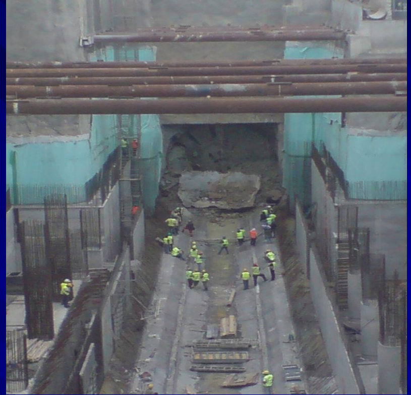
Ξετρύπημα όρυγμα του σταθμού Ηλιούπολη Οκτώβριος 2008
