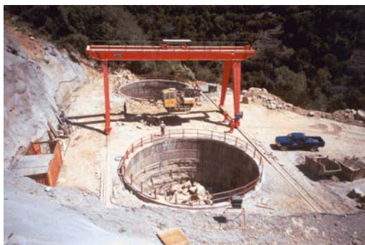
(γ) Γενική άποψη φρεάτων Μ1
