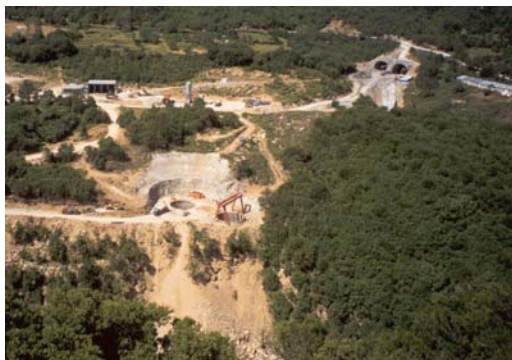
(α) Γενική άποψη φρεάτων Μ1
