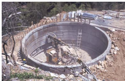
(β) Τοποθέτηση ηλώσεων βράχου. Αρχικά στάδια εκσκαφής
