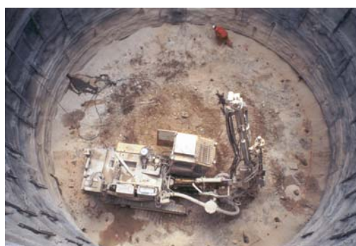
(δ) Διάτρηση και γόμωση οπών με εκρηκτικά για εκσκαφή βραχώμαζας
