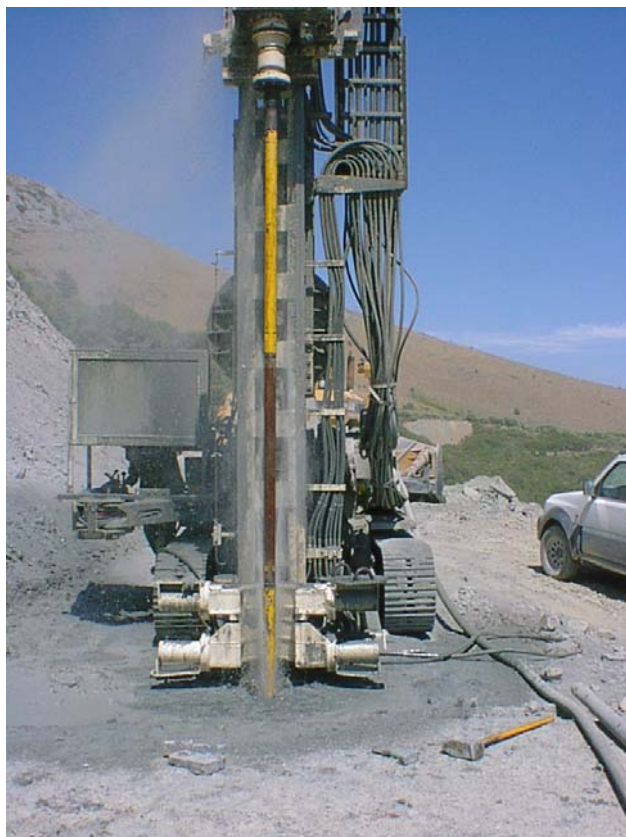
Φωτογραφία 8: Γεώτρηση για την τοποθέτηση οργάνων παρακολούθησης (κλισιόμετρο).
