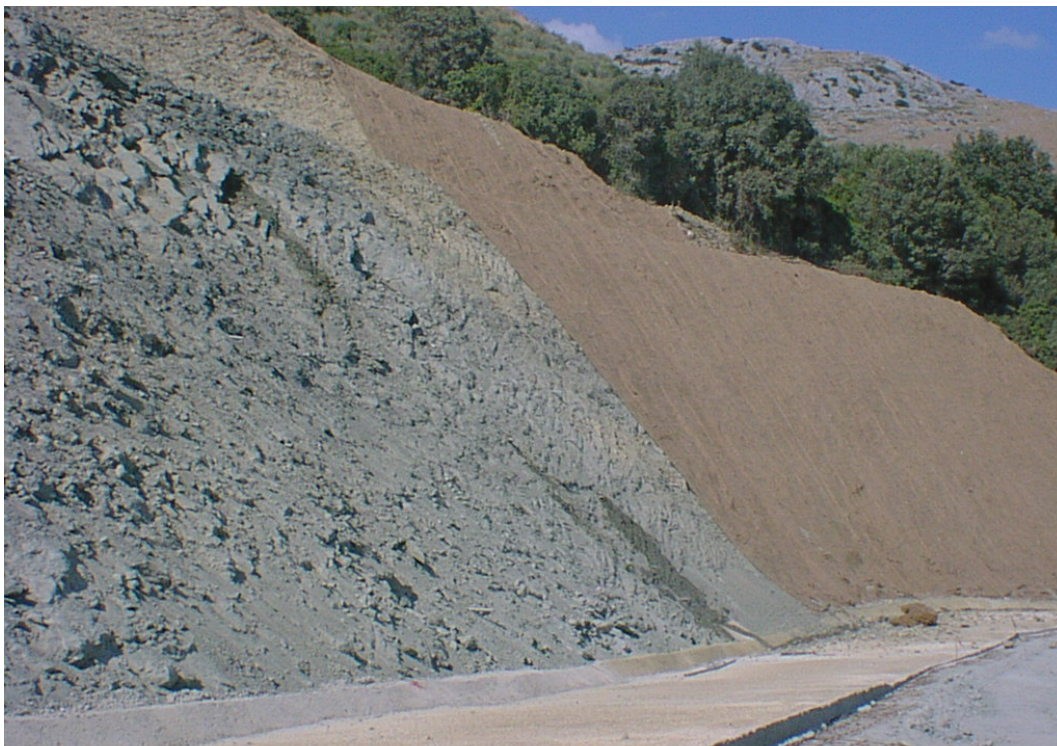
Φωτογραφία 7: Φύλλα Γιούτας στα πρανή των εκσκαφών και σκυροδέτηση αναβαθμού με τοποθέτηση δομικού πλέγματος.
