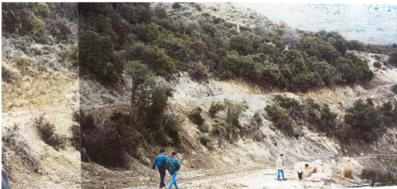
Φωτογραφία 1: Γενική άποψη εισόδου του Cut & Cover στη Χ.Θ. 11+730. Διακρίνεται ο επιφανειακός μανδύας αποσάθρωσης (ελουβιακός μανδύας).
