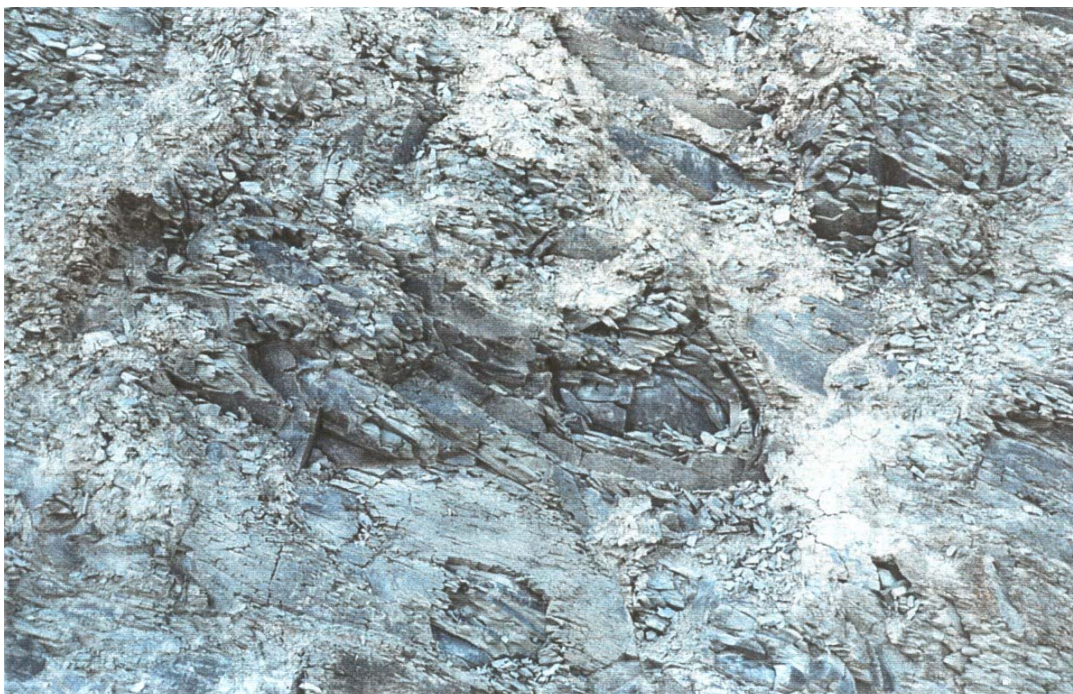
Φωτογραφία 4: Πρανή εκσκαφής όπου διακρίνεται το ιλυολιθικό υπόβαθρο, πολυπτυχωμένο στη θέση αυτή.
