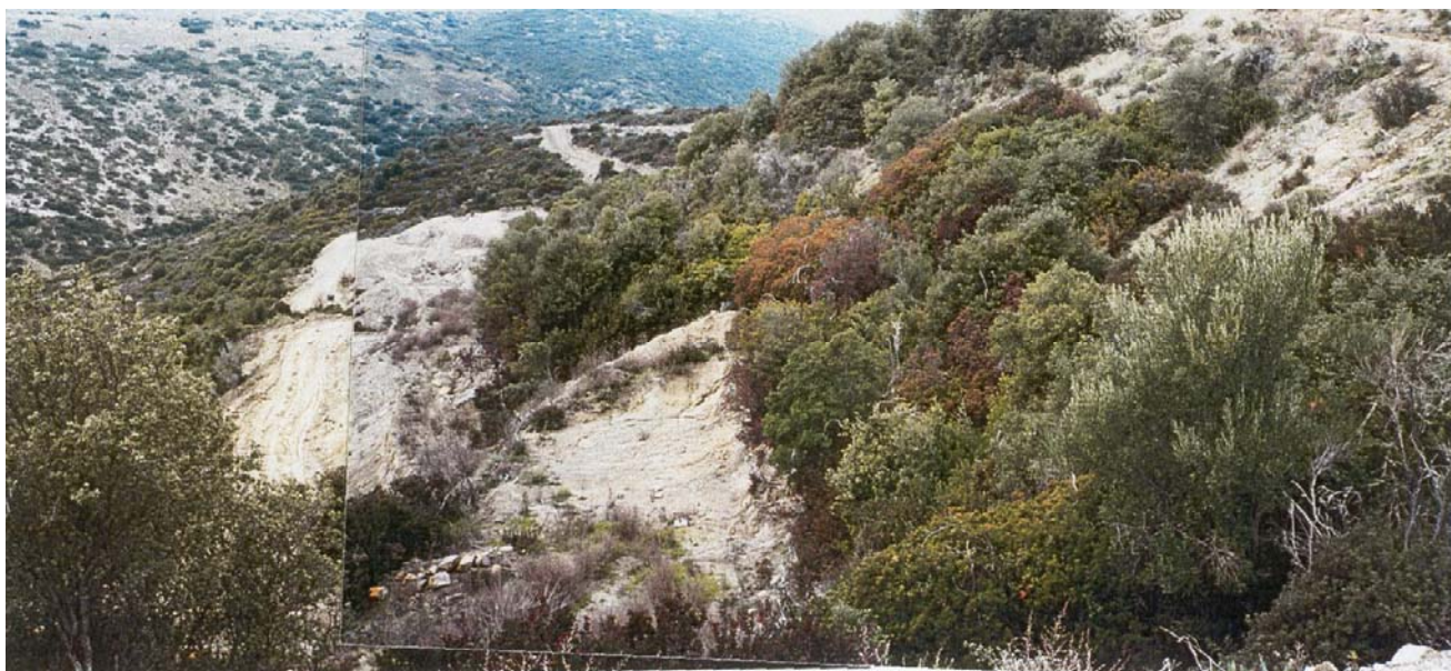
Φωτογραφία 2: Γενική άποψη εισόδου του Cut & Cover στη Χ.Θ. 11+995. Διακρίνεται ο επιφανειακός μανδύας αποσάθρωσης (ελουβιακός μανδύας).
