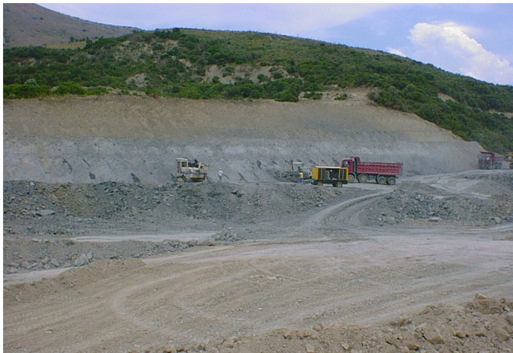
Φωτογραφία 5: Όψη πρανών εκσκαφών και μέτρων προσωρινής αντιστήριξης.
